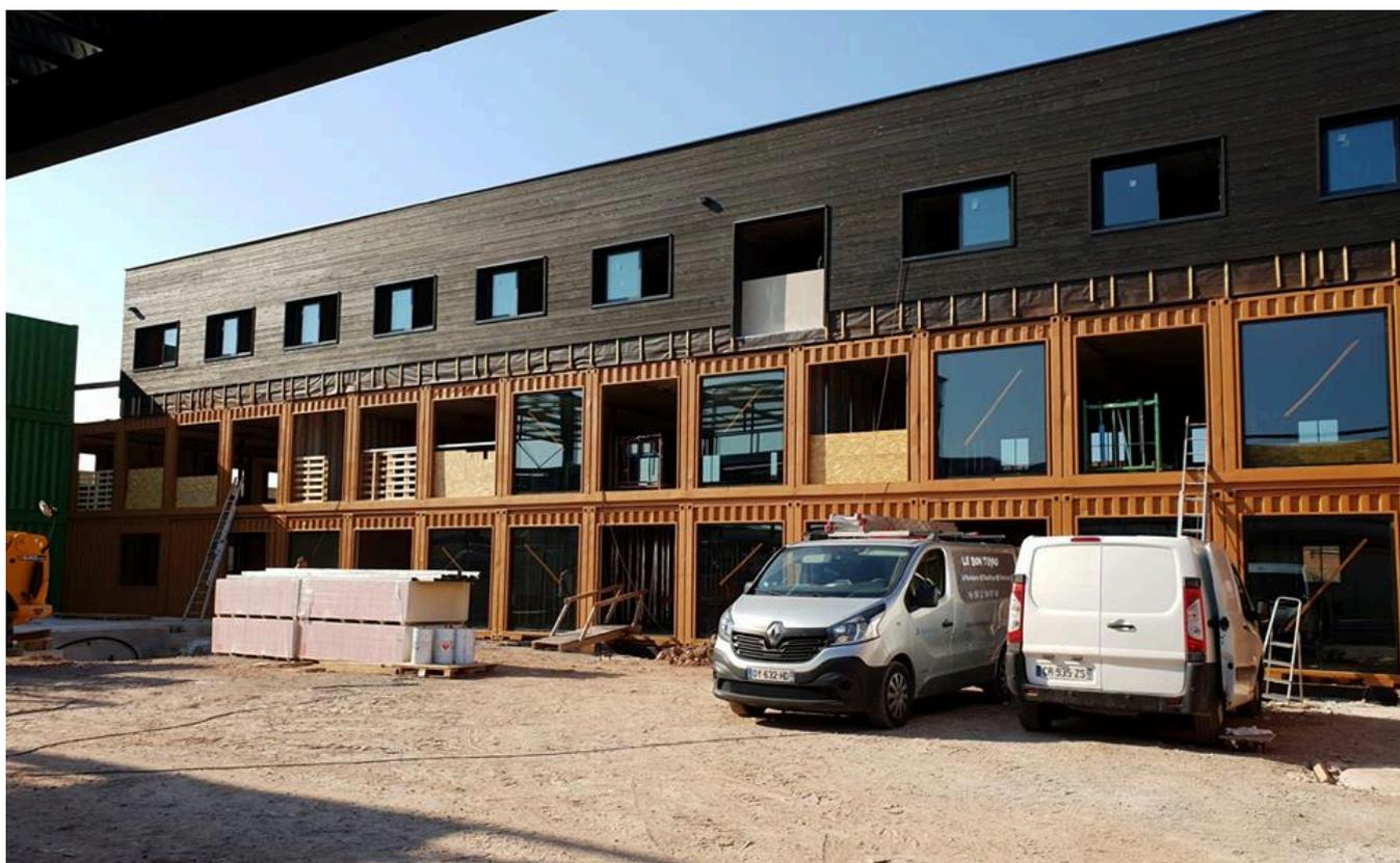
Toutes les portes et fenêtres de la gamme PERFORMANCE 70 ont été **posées en tunnel, dans l'épaisseur des murs**. Pour les parties « bois » et « paille », **deux types de précadres en bois ont été fabriqués sur-mesure**. Lors de la mise en œuvre des menuiseries, les réglages ont dû s'effectuer avec précision en prenant en compte une marge pour la dilatation dans le temps de ce matériau.
