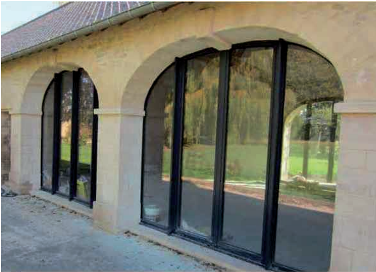
Ensemble cintré en anse de panier à partir de la gamme Performance 70 de Sapa, par Tellier. Réalisation Menuiserie Michel Dutressoules (14).
