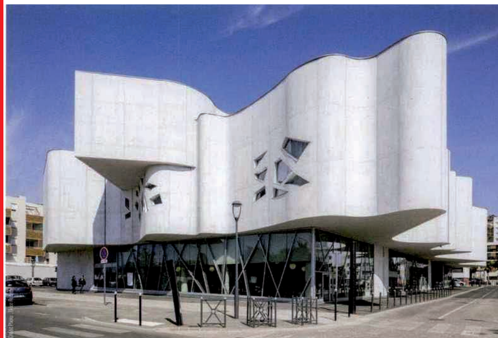
Sapa a habillé la médiathèque la Passerelle à Vitrolles (13)
