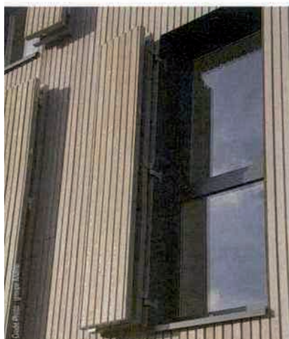
Chantier en cours en Normandie à Maromme (Bouygués), mêlant volets coulissants aluminium (250) et volets battants mixtes bois et aluminium (80 paires) du groupe Maine
