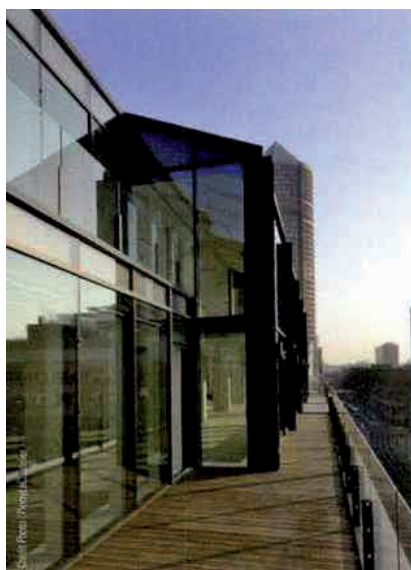
Le 107, restructuration tertiaire, Architecte Soho Atlas, maître d'ouvrage SCI Notapierre pour UNOPI. Mur-rideau Mecano 52, châssis Wicline 65/Wicono, porte battante Absys
